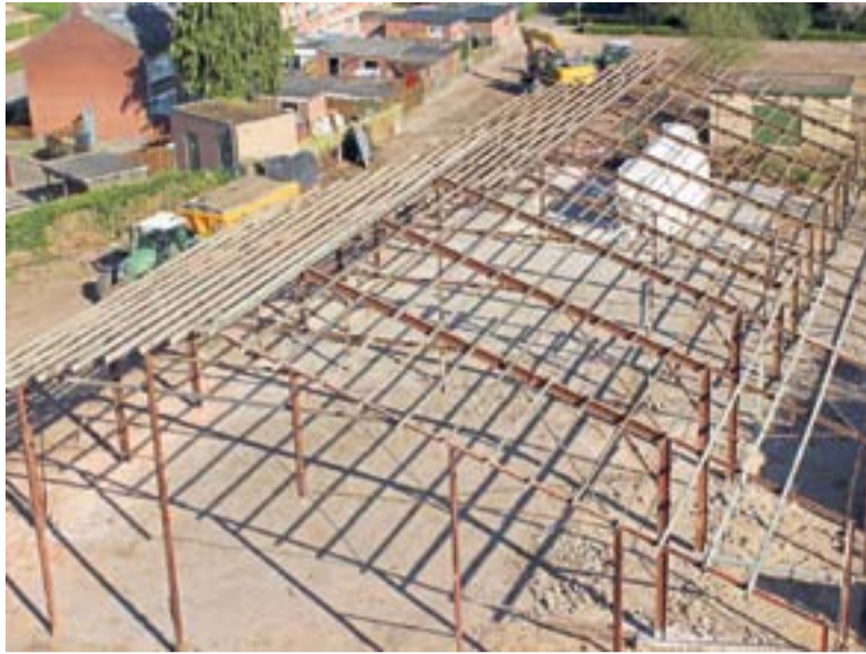
Stalen spanten is alles wat nog overeind staat op het bedrijfsterrein van De Weerd Tenten. De tentwasinstallatie (wit) staat ingepakt.
