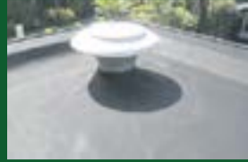
EPDM dakbedekking ALU daktrim
