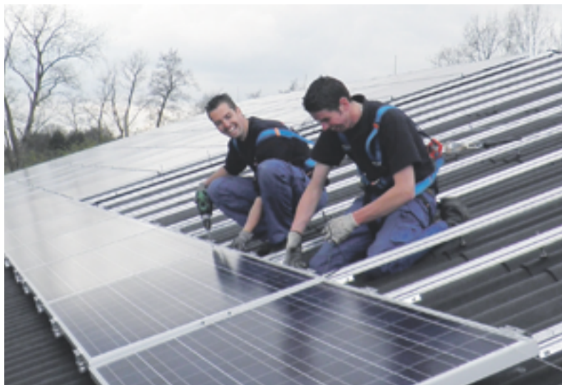
Ronald Barmantloo en Bart van de Belt van Ten Hove totaalinstallateur plaatsen de zonnepanelen op het dak van Vitalis
