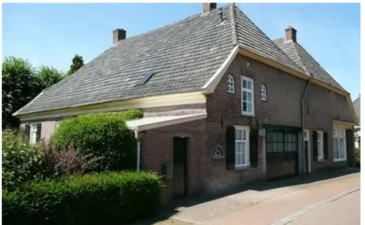
Foto van de achterkant van de Rageboomshofstede in de huidige situatie
