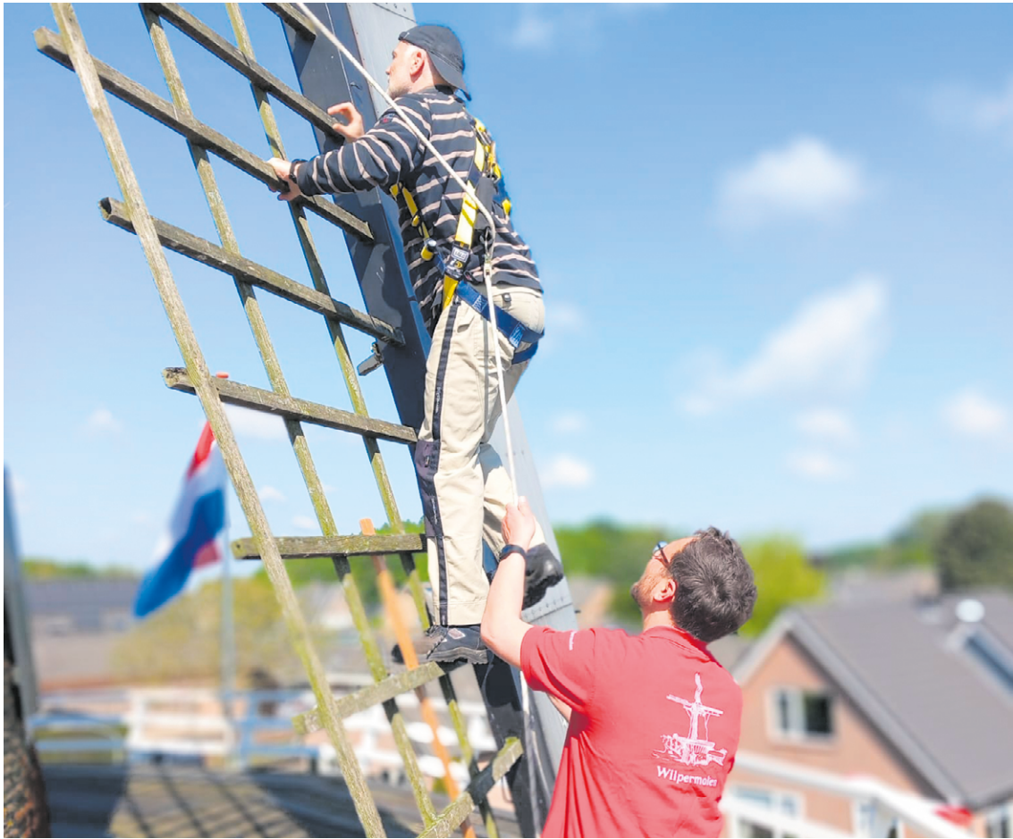
De zeilen worden aan de wieken bevestigd.
