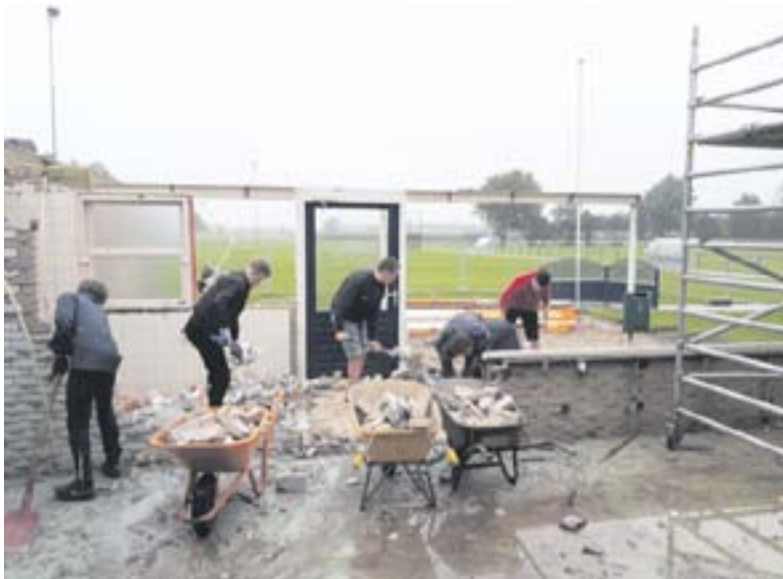
Er wordt hard gewerkt aan het clubgebouw in Wilp.
