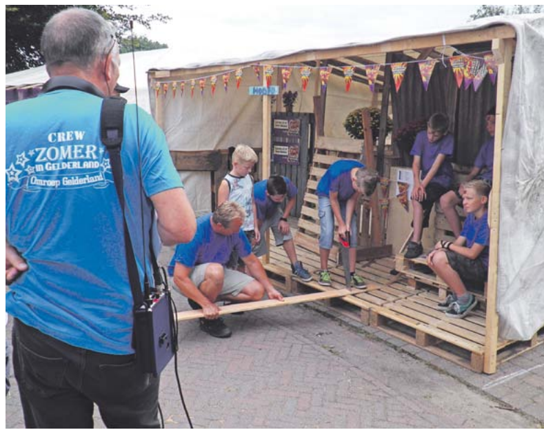
De laatste werkzaamheden aan de veranda
