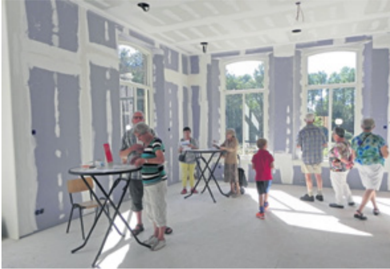
Eén van de grote ruimtes op de begane grond.
