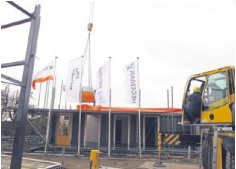
Wethouder Jan van Muyden was bereid om de eerste wand te plaatsen als symbool voor de start van de nieuwbouw.
