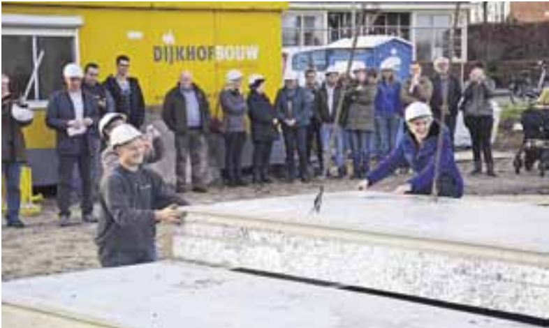
De laatste vloerplaat werd door de eerste koper, mevrouw Lisette Downer-Bouwmeester gelegd. Op de achtergrond ziet u o.a. de nieuwe bewoners.
