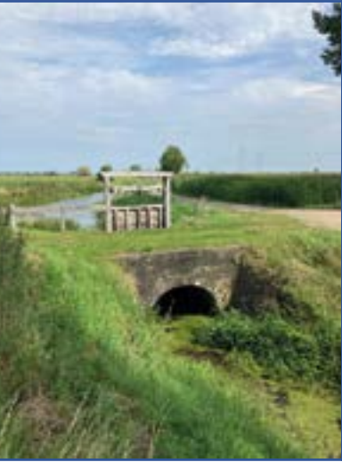
Het sluisje aan de Vloeddijk in Nijbroek
