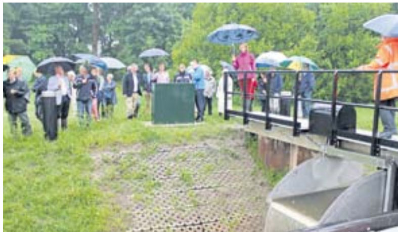
Willem de Beaufort (links van de schakelkast) heeft zojuist de nieuwe stuw in werking gesteld
