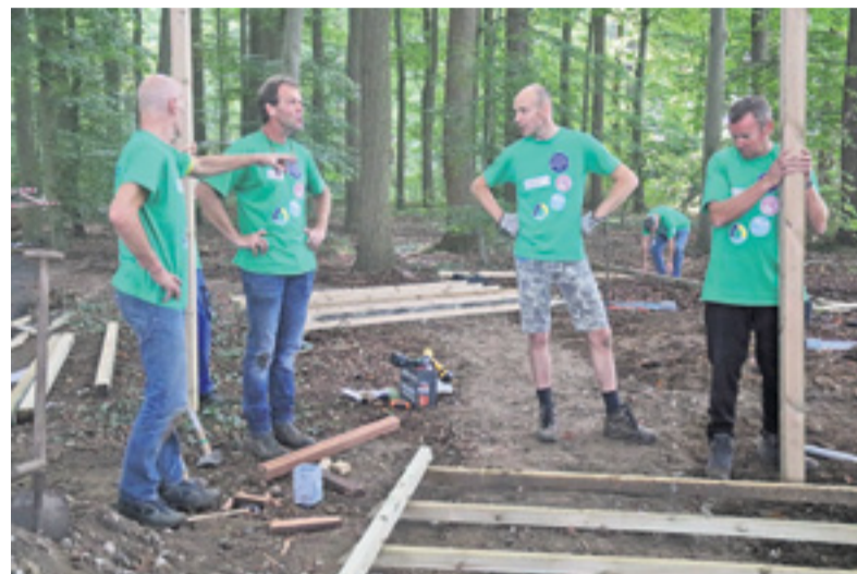
Pergola in aanbouw.
